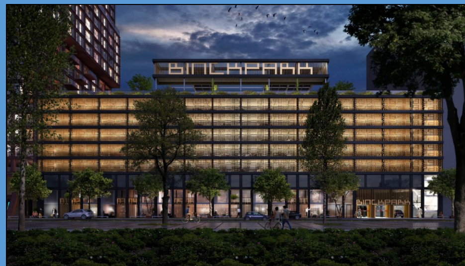
Praktijkvoorbeeld Binckpark als centrale parkeervoorziening (bron: Continental Car Parks)
